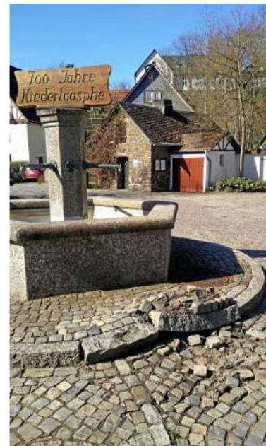
Der Dorfbrunnen auf dem Brückenplatz in der Ortsmitte ist mal wieder beschädigt – offenbar durch einen Lkw, der hier die Kurve nicht gekriegt hat.
