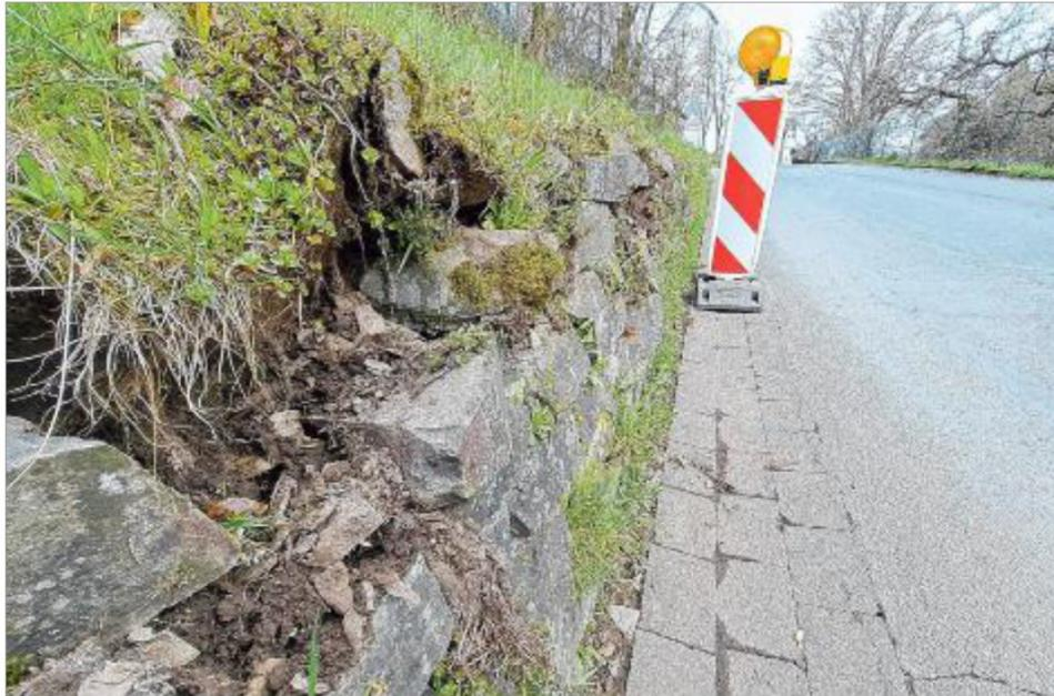
*Die Vollsperrung der B62 hinterlässt in Niederlaasphe selbst immer mehr Spuren. Auch die Trockenmauer am Schulberg wurde erheblich beschädigt. Foto: Christian Völkel*
