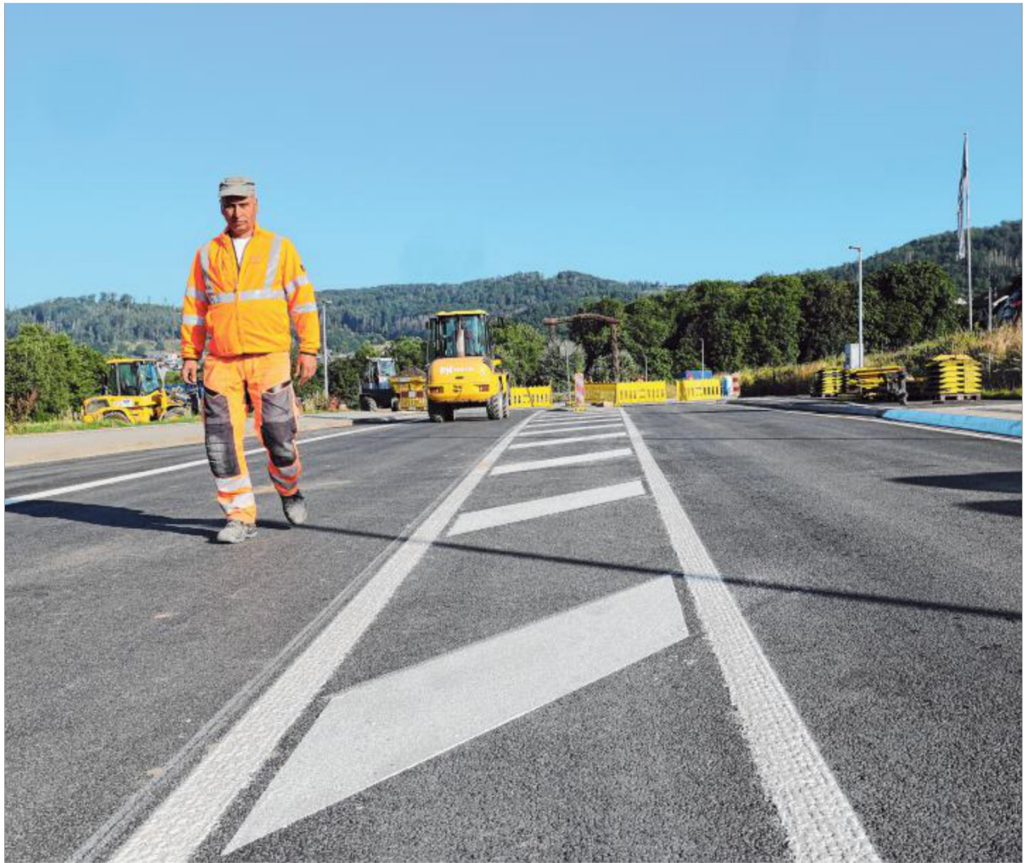
Die Arbeiten zur Erneuerung der Bundesstraße 62 in Niederlaasphe, die eine monatelange Vollsperrung erforderlich machten, sind nahezu abgeschlossen.
