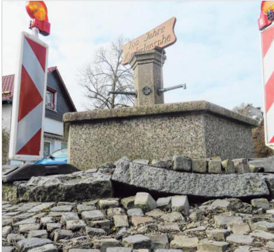
Vollsperrung mit Folgen: Der Niederlaaspher Brunnen wurde durch den Schwerlastverkehr erheblich beschädigt. ■ Rechtes Bild: Der Zustand der Rainstraße war schon vor der Vollsperrung und der riesigen Menge an Fahrzeugen bedenklich.
