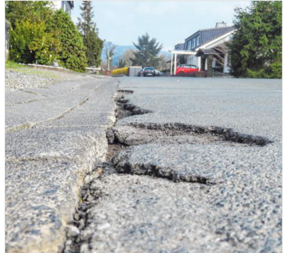
Vollsperrung mit Folgen: Der Niederlaaspher Brunnen wurde durch den Schwerlastverkehr erheblich beschädigt. ■ Rechtes Bild: Der Zustand der Rainstraße war schon vor der Vollsperrung und der riesigen Menge an Fahrzeugen bedenklich.
