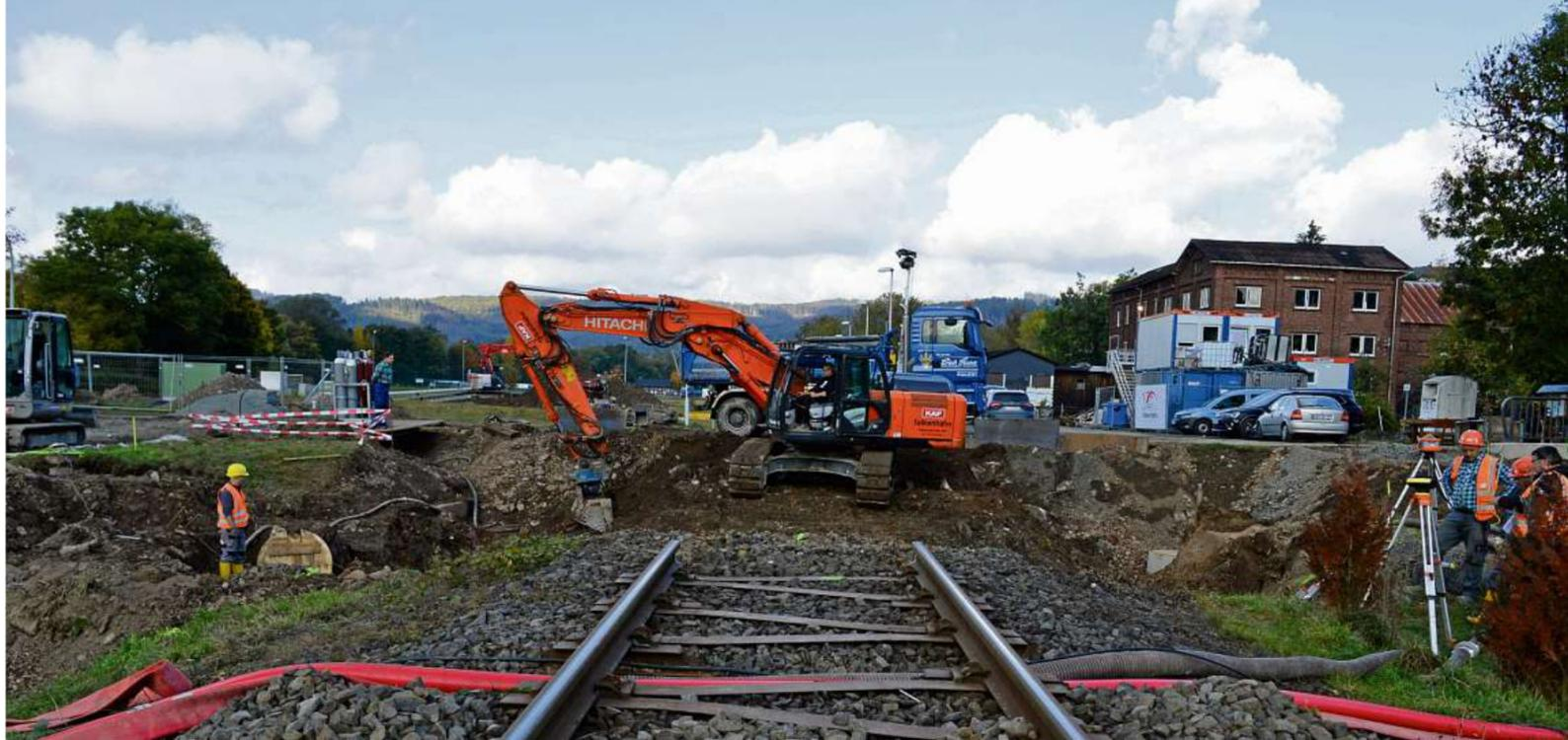
Kurz vor dem Niederlaasphe Bahnsteig: Das Gleis ist gekappt, die Bauarbeiten für die neue Brücke sind voll im Gange.
